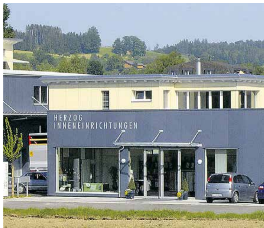
Herzog AG, Inneneinrichtungen, Grosswangen. Foto pd
